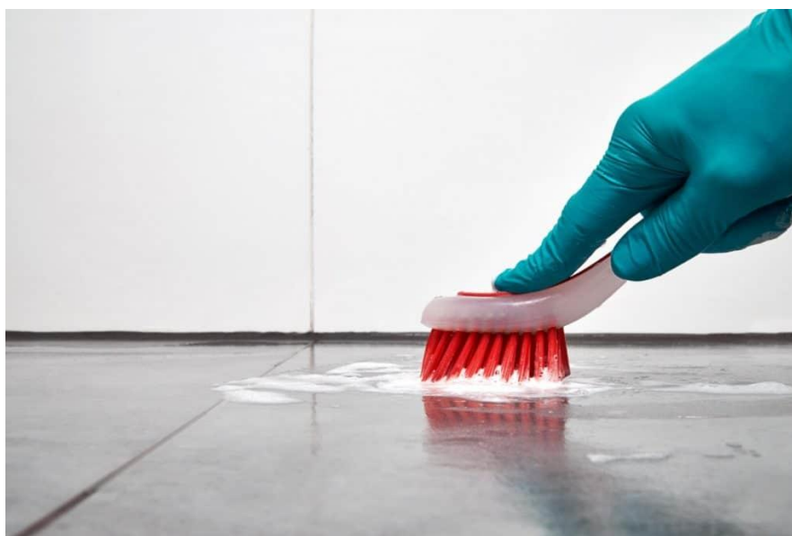
ภาพที่ ๕ ทำความสะอาดร่องยาแนวและคราบขาวบนพื้น
